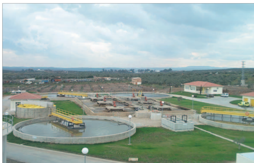
PLANTA. El problema está en la dosificación del carbón activo de la potabilizadora.
