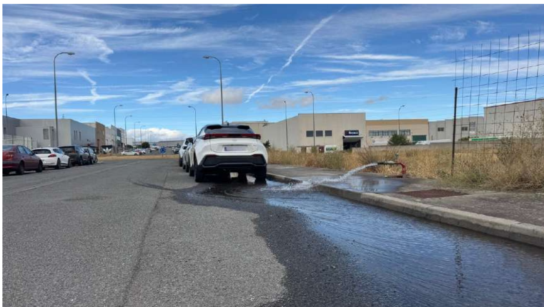
Boca de riego vaciando el agua de la red en el polígono de Vicolozano durante el episodio de manganeso
