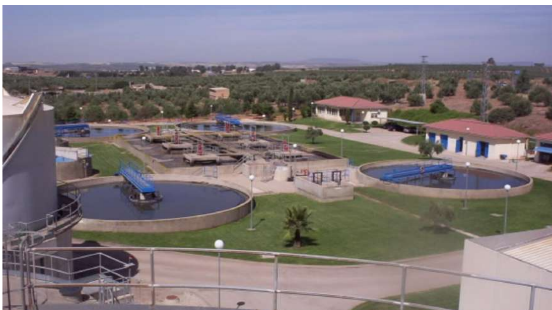
Depuradora de aguas residuales de Linares. / Linaqua
